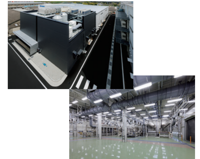
2026年1月から稼働開始した加美工場（第1期工事） 外観と内部の様子
