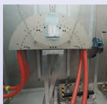
Cable hoisting device ケーブル昇降装置
