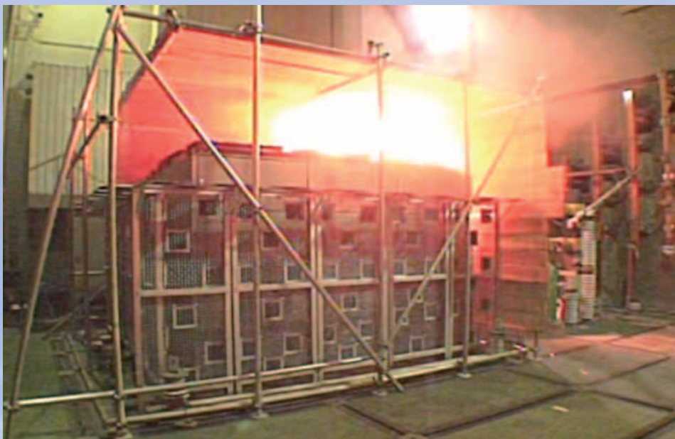
View of Internal Arcing Test 内部アーク試験風景
